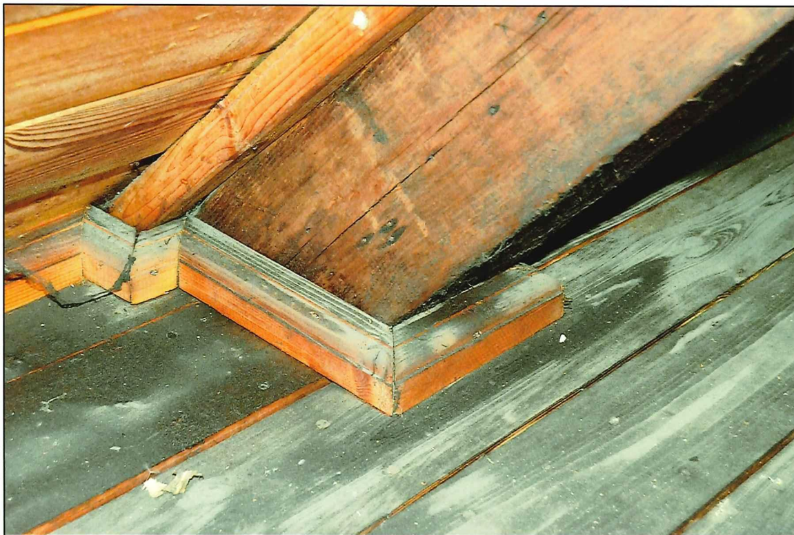
Il. 244 Golub-Dobrzyń, Rynek 19 – dom podcieniowy – konstrukcja dachowa - widok na fragment krokwi, podbitki i podłogi
