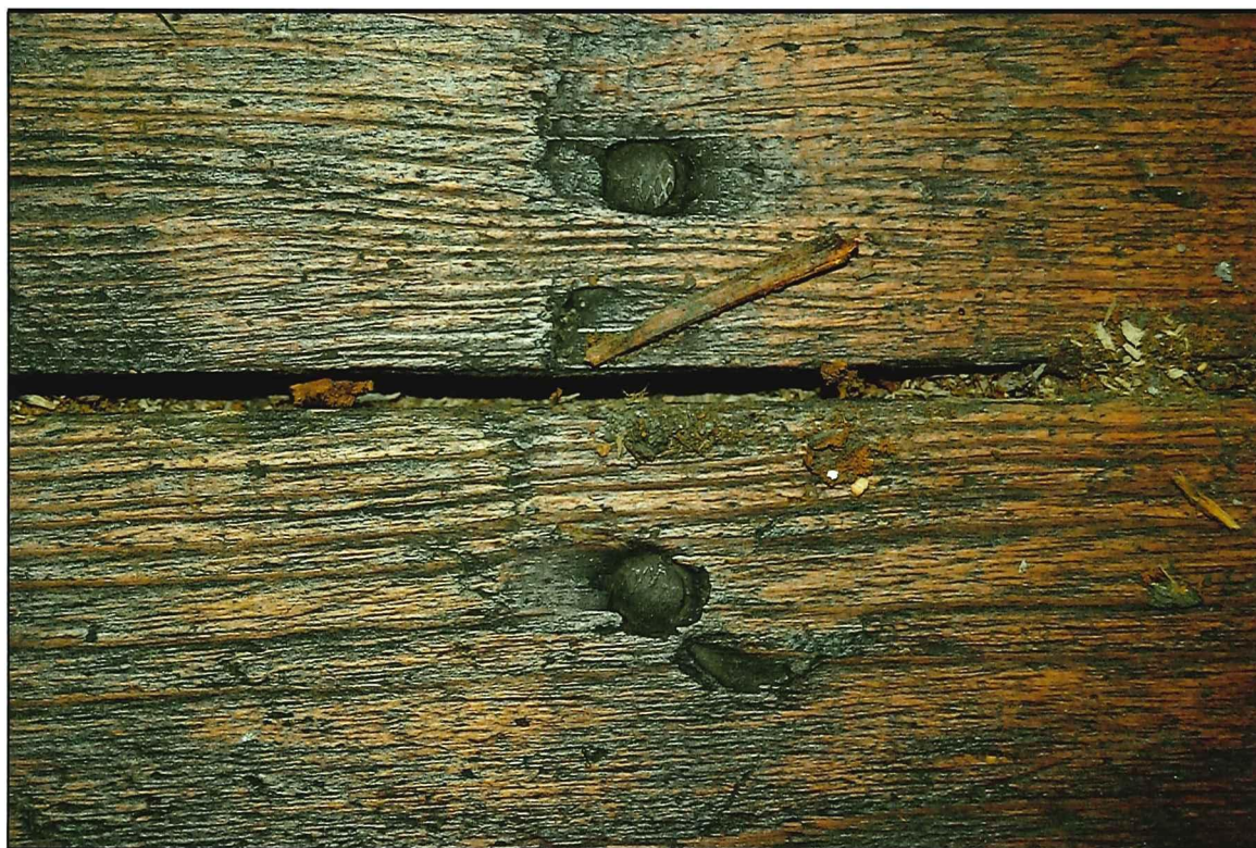
Il. 175 Golub-Dobrzyń, Rynek 19 – dom podcieniowy, przyziemie - izba, widok na podłogę białą z desek sosnowych przybijanych gwoździami
