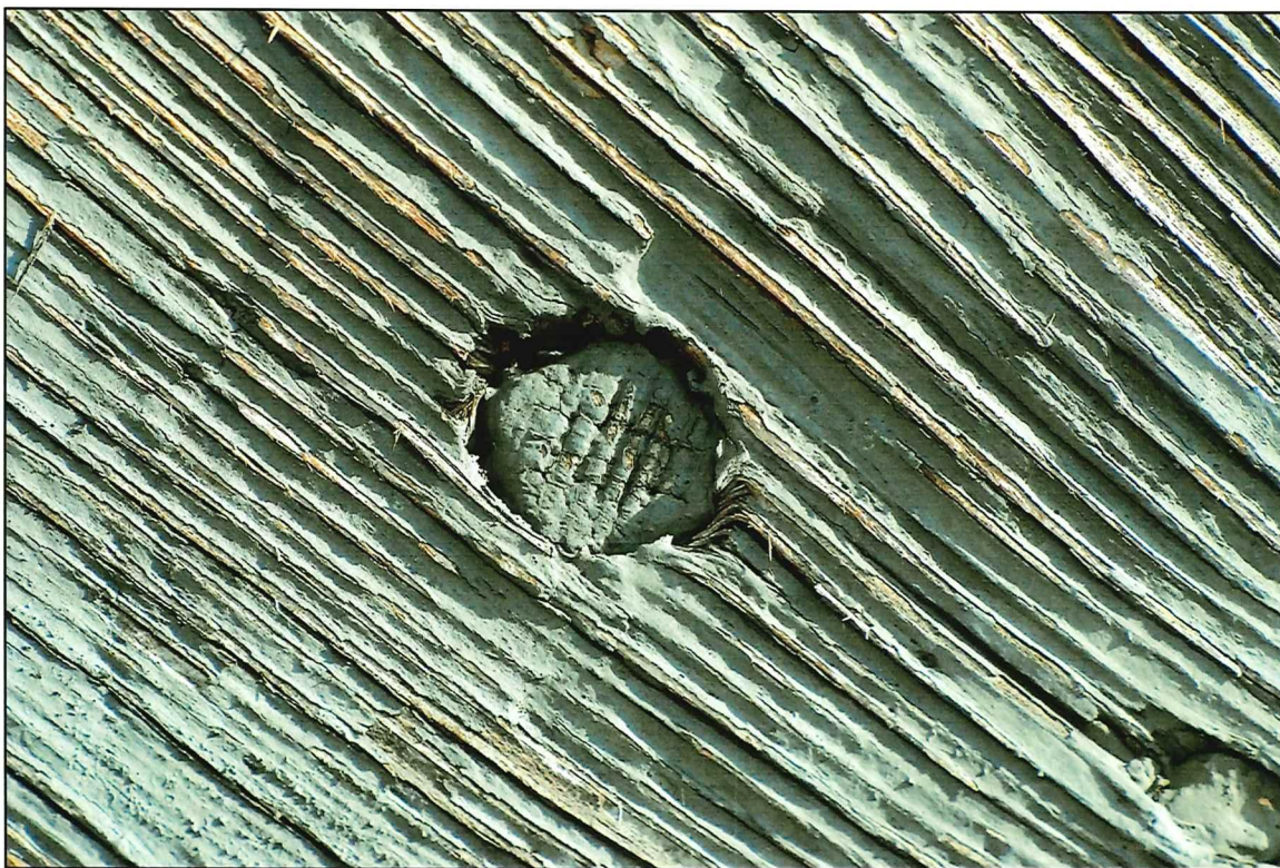
Il. 86 Golub-Dobrzyń, Rynek 19 – dom podcieniowy – podcień - fragment drewnianej powierzchni miecza zabezpieczonej farbą elewacyjną
