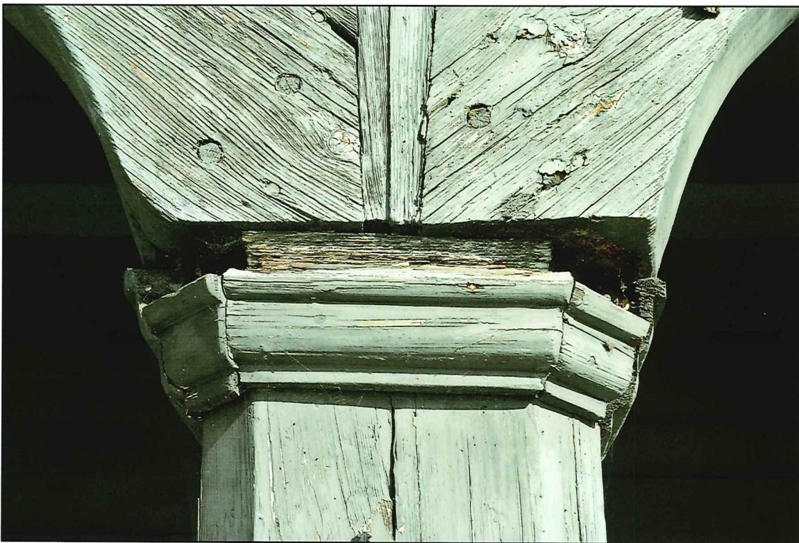
Il. 83 Golub-Dobrzyń, Rynek 19 – dom podcieniowy – podcień - widok na zniszczenia słupa środkowego
