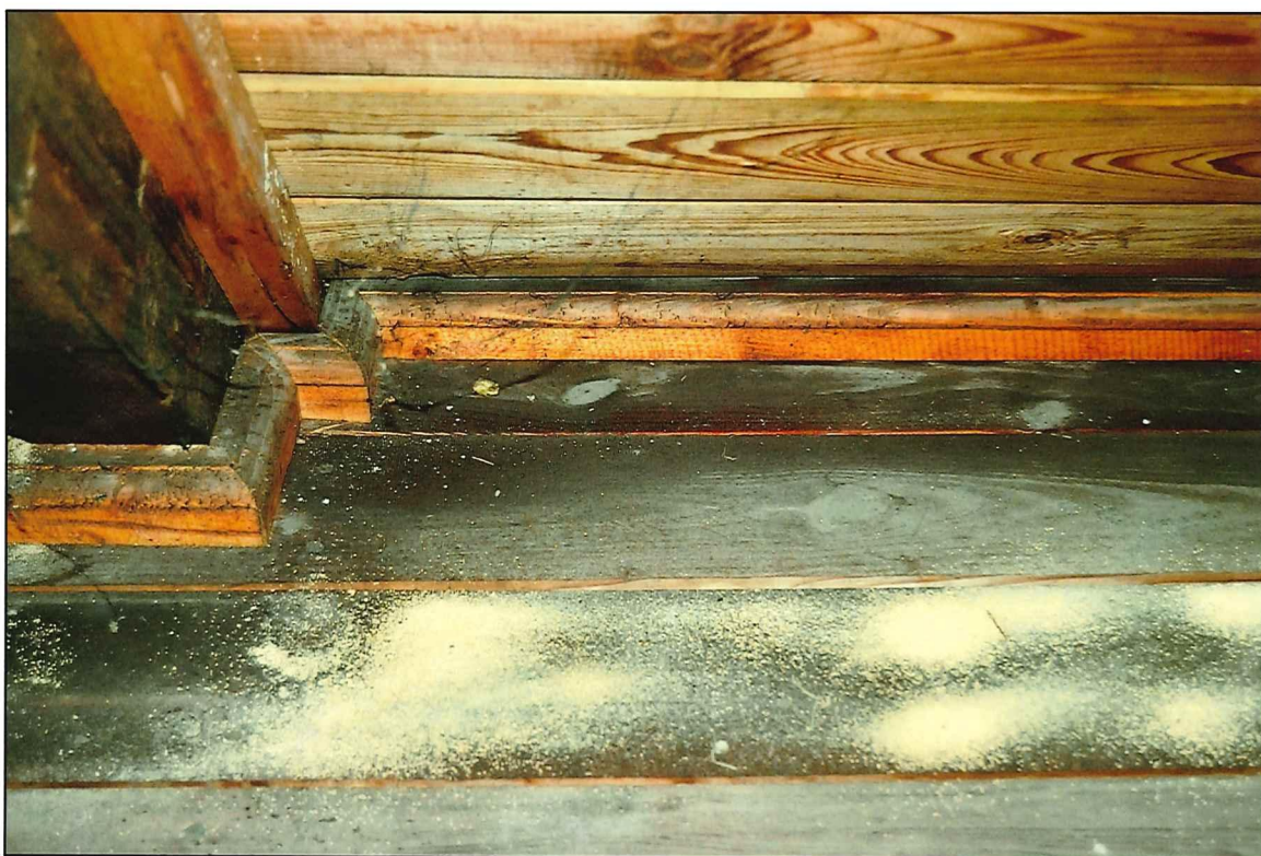
II. 249 Golub-Dobrzyń, Rynek 19 – dom podcieniowy – konstrukcja dachowa - widok na mączkę drzewną, będącą dowodem żerowania drewnojadów w deskowaniu pokrycia
