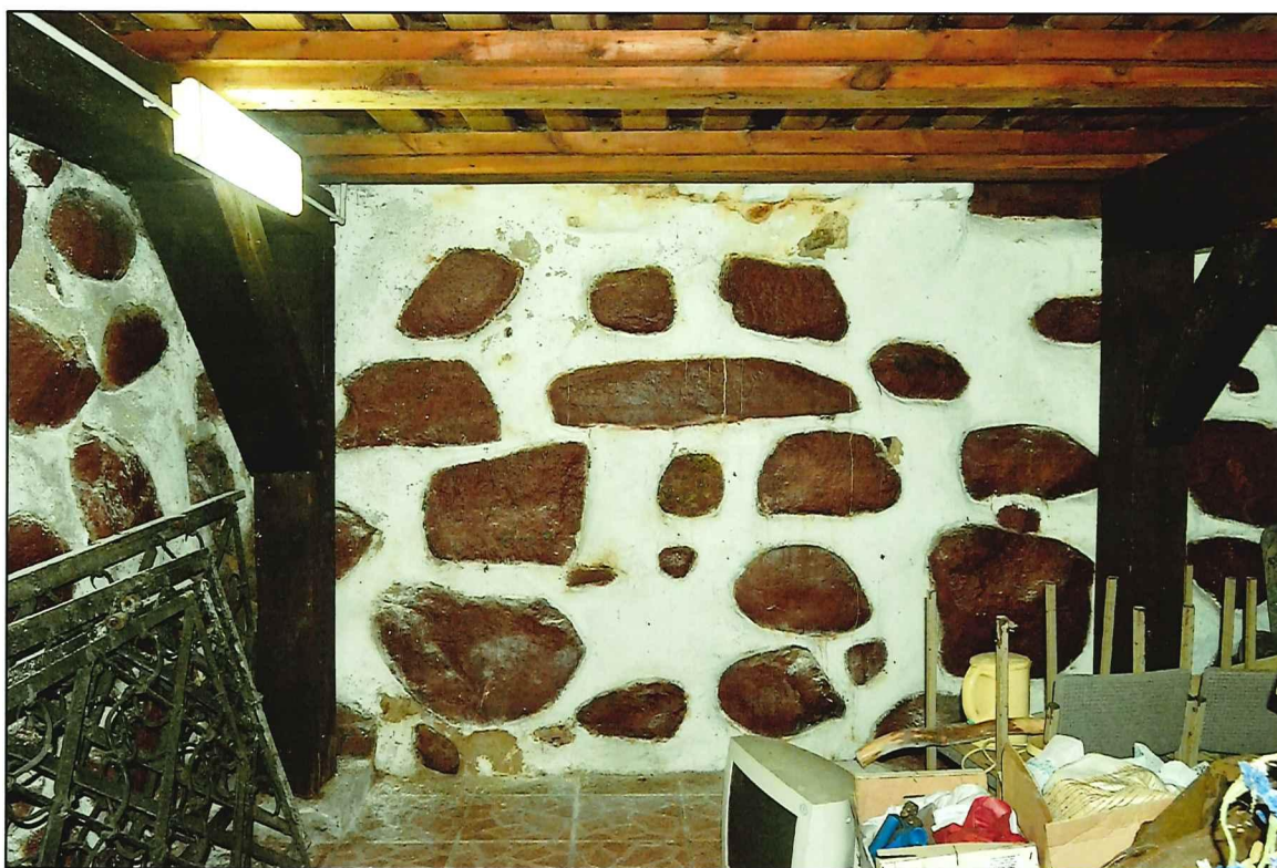
Il. 123 Golub-Dobrzyń, Rynek 19 – dom podcieniowy – piwnica - widok na fragment ściany wschodniej oraz ramy stolcowe
