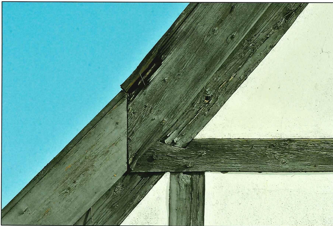
Il. 67 Golub-Dobrzyń, Rynek 19 – dom podcieniowy – szczyt szkieletowy - widok na fragment krokwi, jętki oraz wiatrownicy
