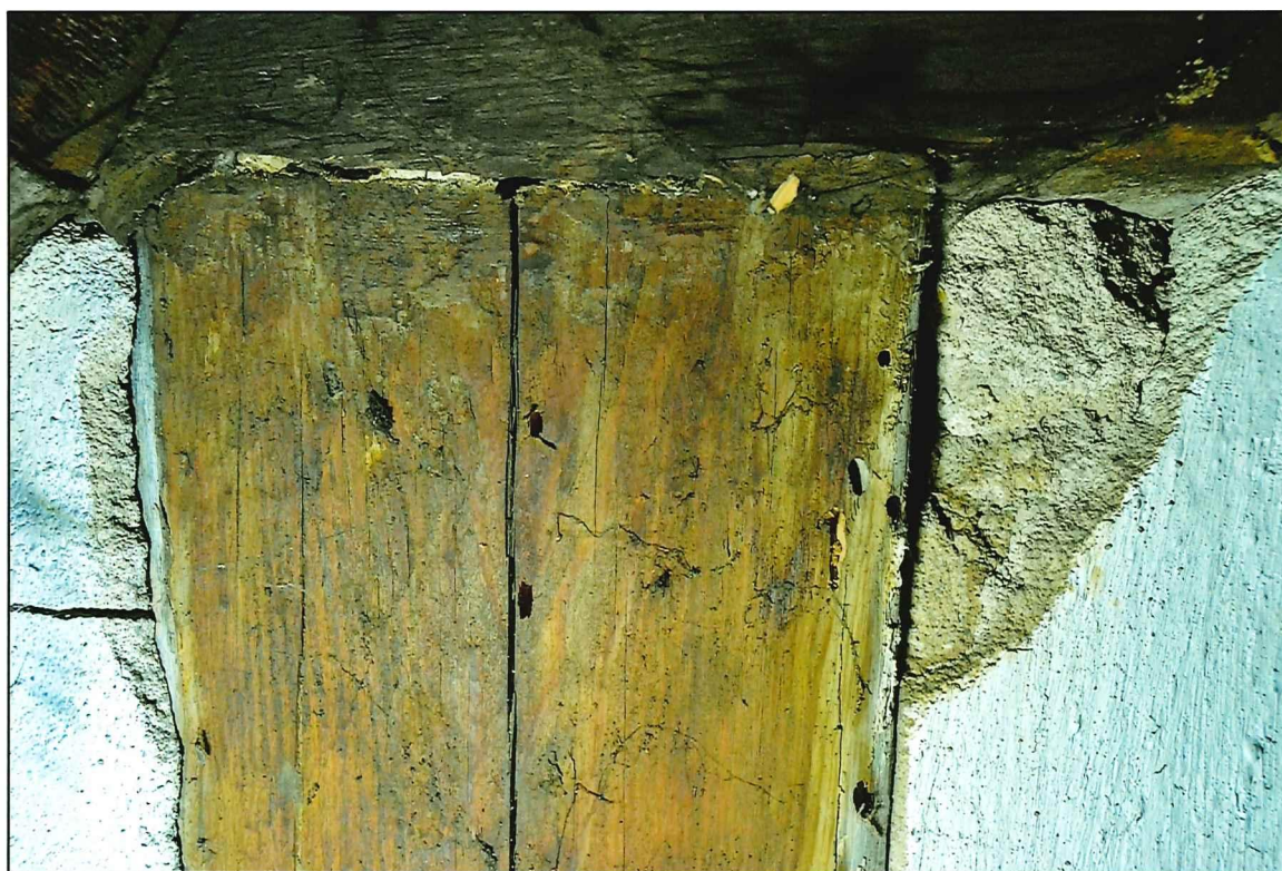
Il. 269 Golub-Dobrzyń, Rynek 19 – dom podcieniowy – szczyt zachodni - widok na fragment konstrukcji szkieletowej szczytu ze śladami żerowania drewnojadów
