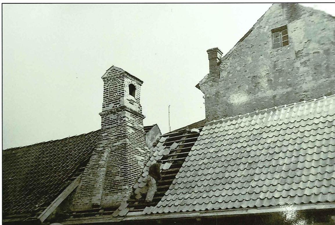
Il. 12 Golub-Dobrzyń, Rynek 19 – dom podcieniowy podczas prac remontowych w 1963 r. - wid połąć dachową północną podczas montażu nowej dachówki ceramicznej
