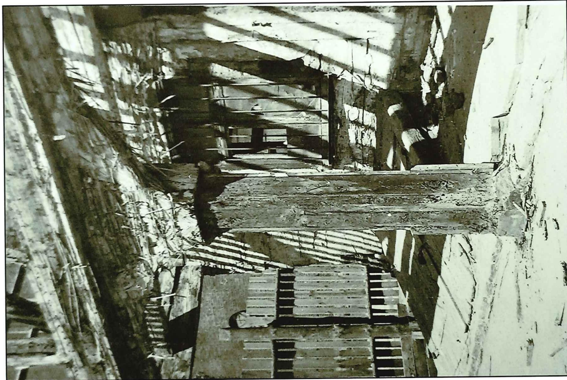
Il. 21 Golub-Dobrzyń, Rynek 19 – dom podcieniowy podczas prac remontowych w 1963 r. - widok na fragment konstrukcji drewnianej podcienia
