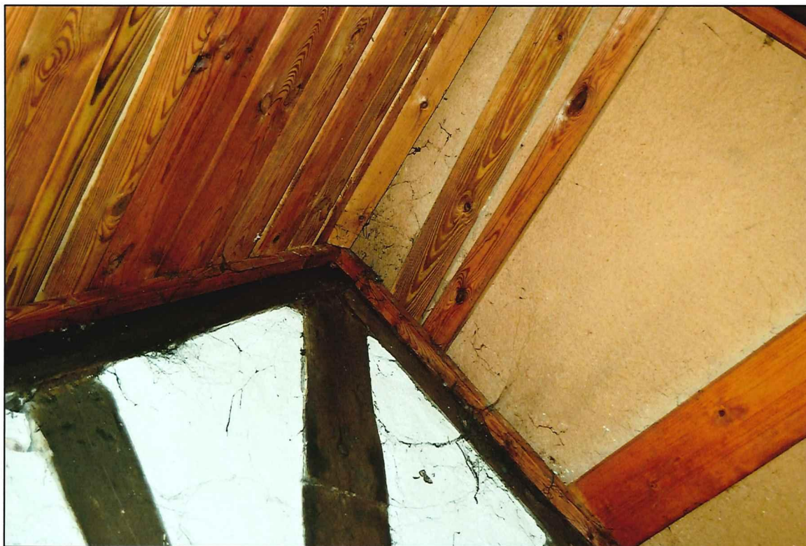
II. 251 Golub-Dobrzyń, Rynek 19 – dom podcieniowy – konstrukcja dachowa - widok na zniszczoną podbitkę deskową połaci północnej
