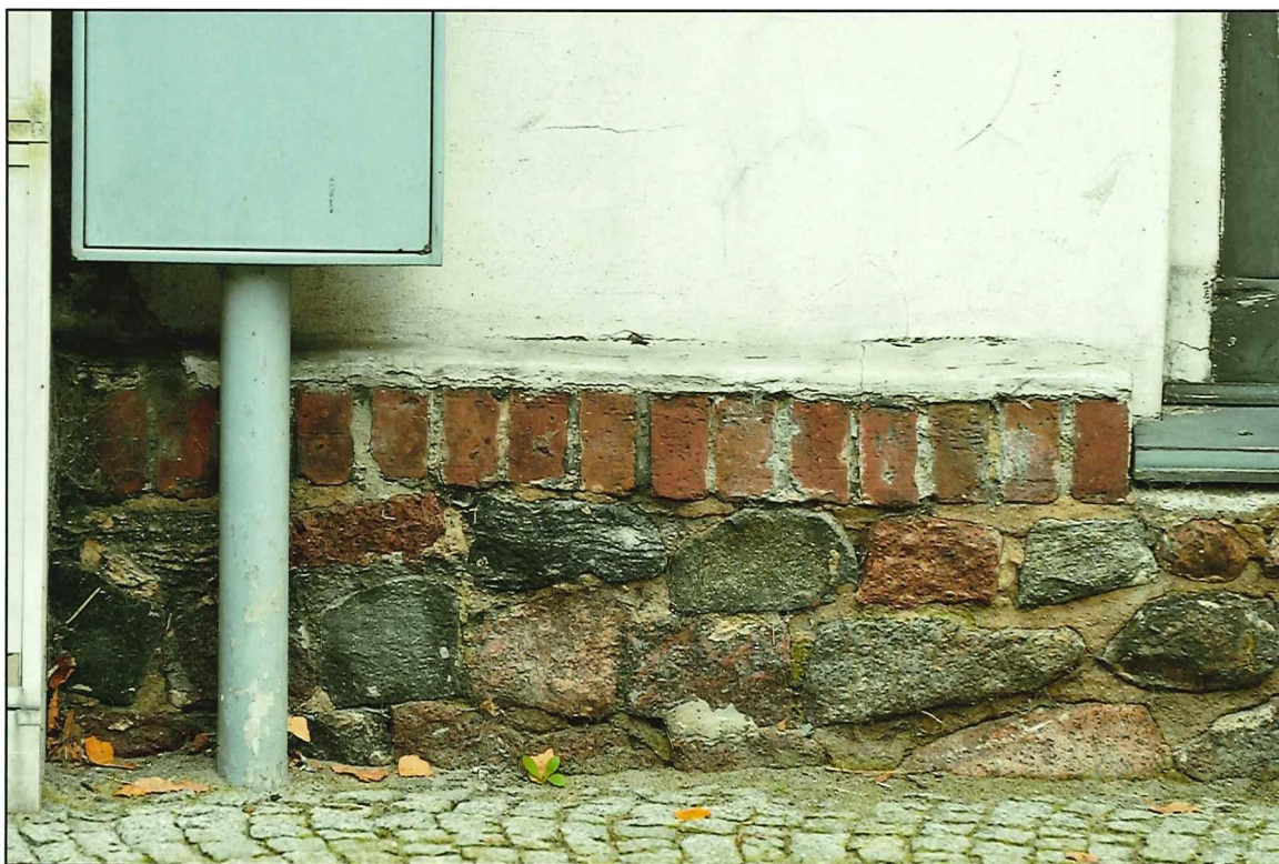
Il. 109 Golub-Dobrzyń, Rynek 19 – dom podcieniowy, ściana północna - widok na fragment kamiennego-ceglanego cokółu
