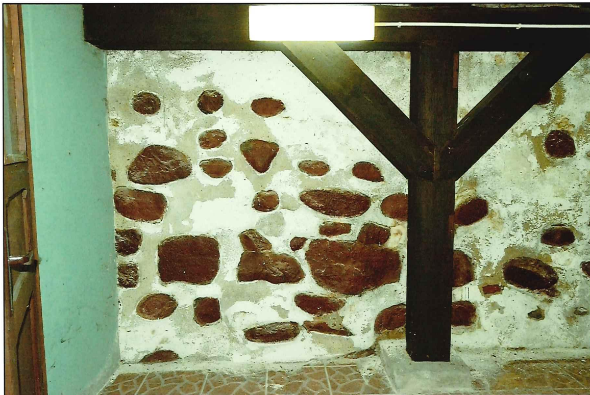
Il. 120 Golub-Dobrzyń, Rynek 19 – dom podcieniowy, piwnica - widok na ścianę i ramę stolcową północną
