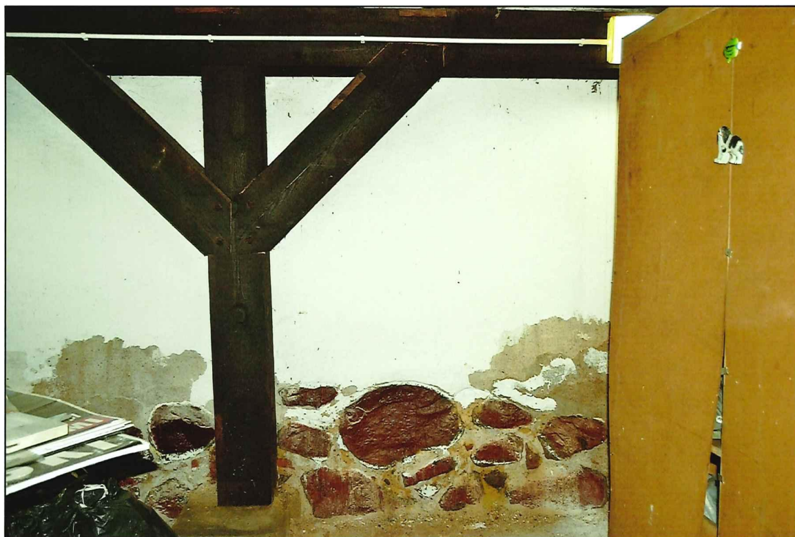
Il. 125 Golub-Dobrzyń, Rynek 19 – dom podcieniowy – piwnica - widok na fragment ściany południowej oraz środkowy stolec ramy stolicowej
