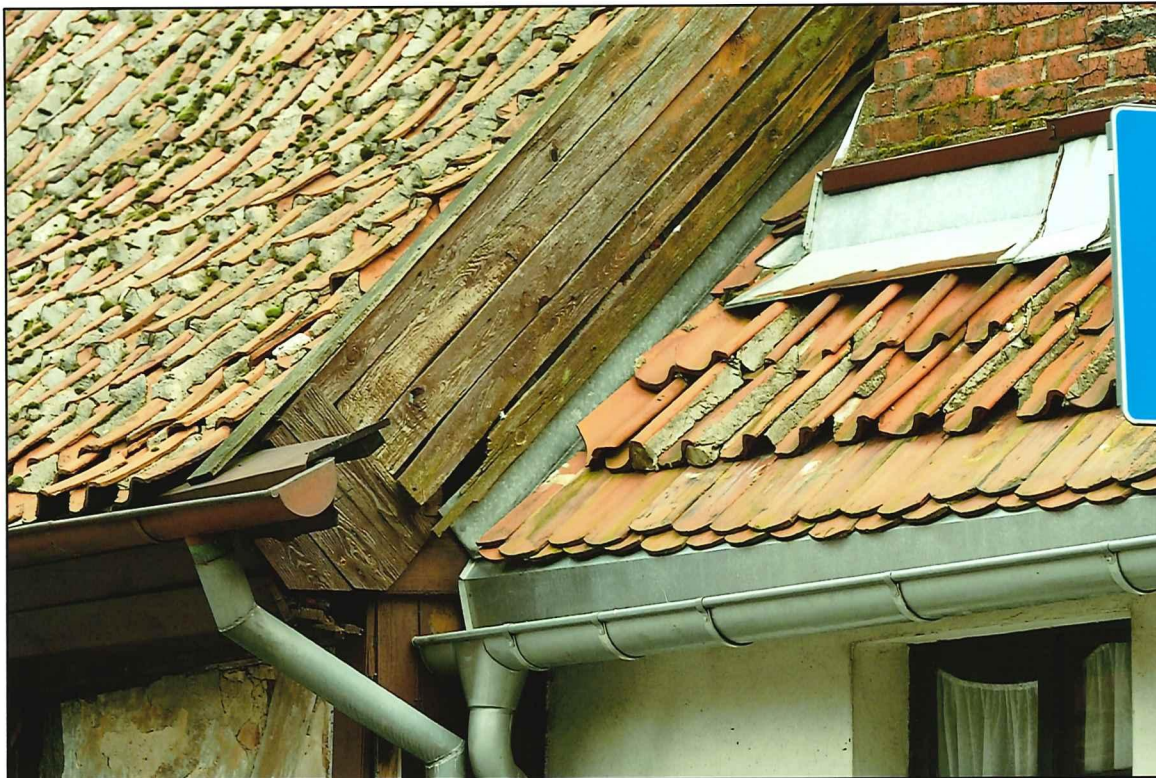
II. 235 Golub-Dobrzyń, Rynek 19 – dom podcieniowy – pokrycie dachowe - widok na połączenie połaci północnej ze szczytem
