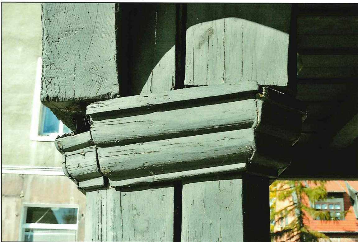
Il. 82 Golub-Dobrzyń, Rynek 19 – dom podcieniowy – podcień - widok na zniszczenia słupa północnego
