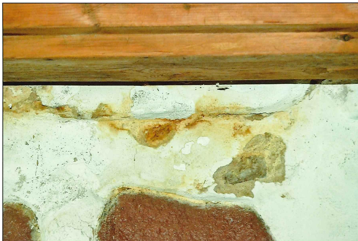
Il. 137 Golub-Dobrzyń, Rynek 19 – dom podcieniowy – piwnica - widok na zawilgocenia ściany wschodniej
