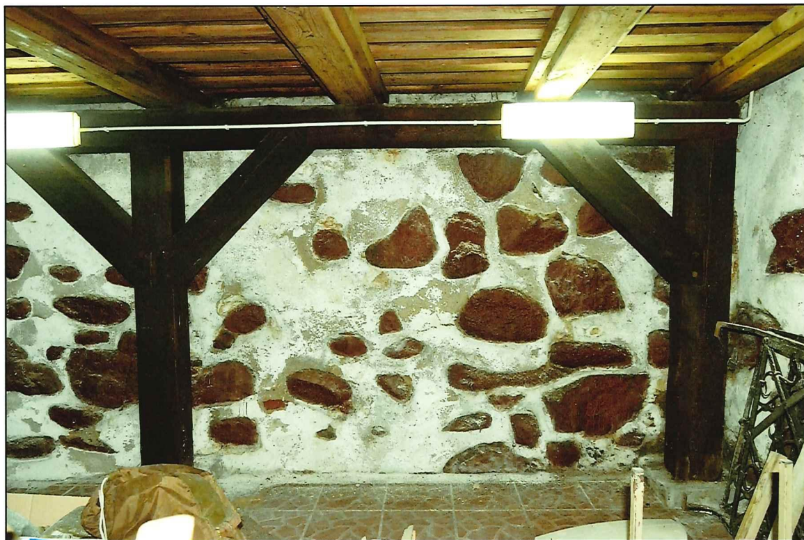
Il. 121 Golub-Dobrzyń, Rynek 19 – dom podcieniowy – piwnica - widok na fragment konstrukcji drewnianej – połączenie czepów ze słupem podcienia
