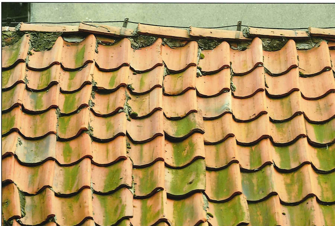
Il. 226 Golub-Dobrzyń, Rynek 19 – dom podcieniowy – pokrycie dachowe - widok na fragment połaci północnej przekrytej ceramiczną dachówką esówką
