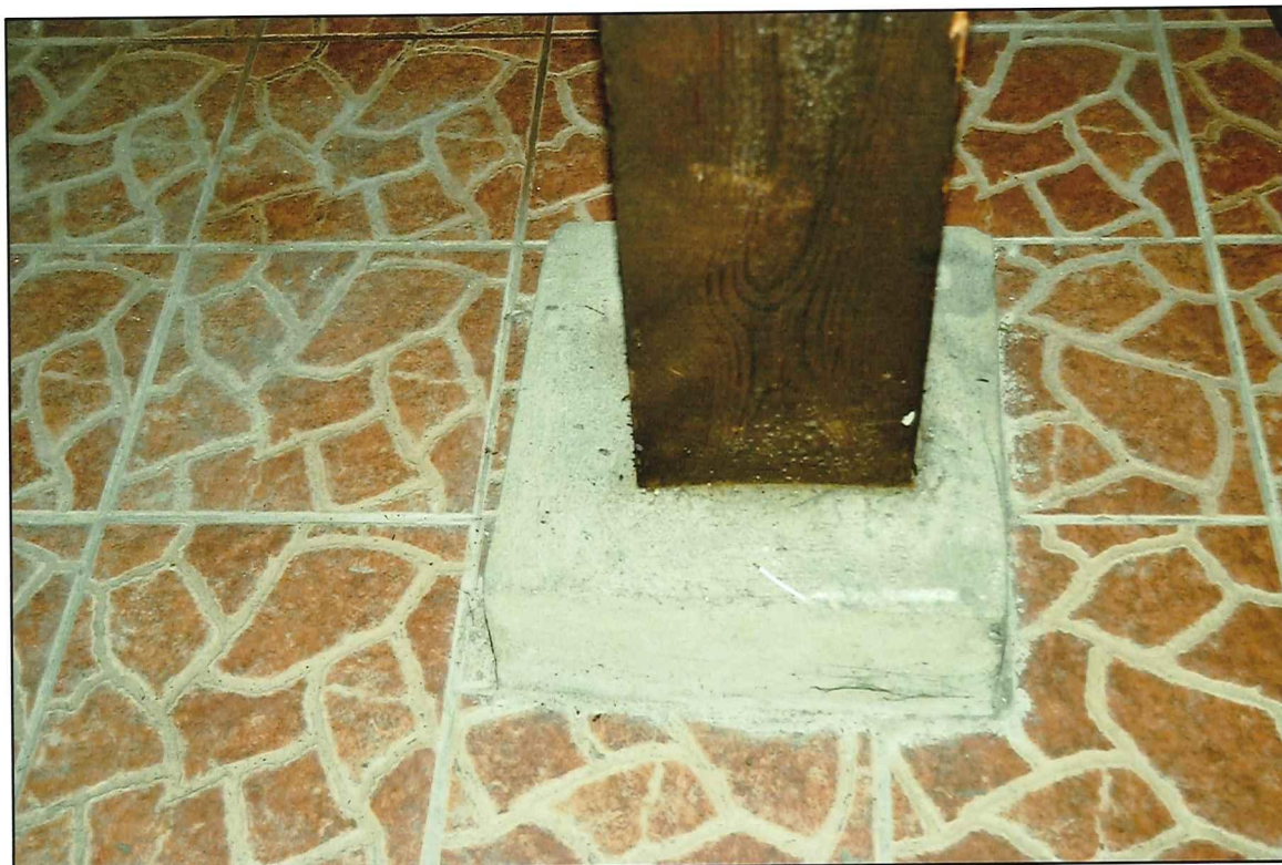
II. 153 Golub-Dobrzyń, Rynek 19 – dom podcieniowy – piwnica - widok na wtórną posadzkę ceramiczną oraz stopę stolca
