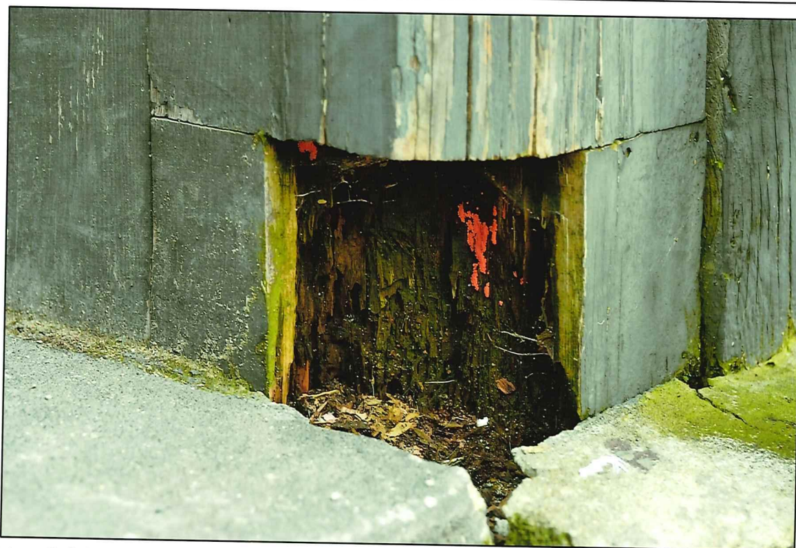
Il. 93 Golub-Dobrzyń, Rynek 19 – dom podcieniowy – podcień - widok na zniszczony wewnętrznie trzon słupa południowego
