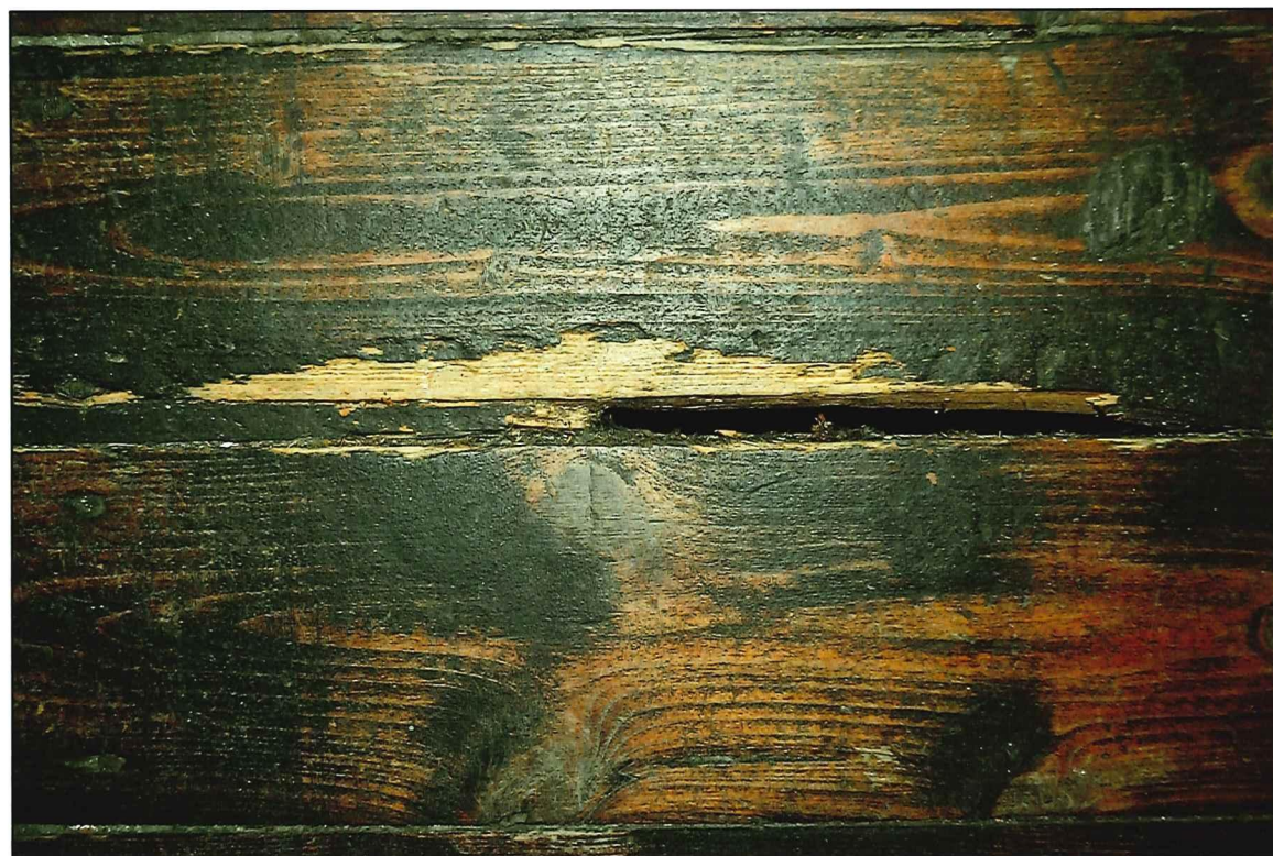
Il. 177 Golub-Dobrzyń, Rynek 19 – dom podcieniowy, przyziemie - izba, widok na miejscowe zniszczenie podłogi deskowej
