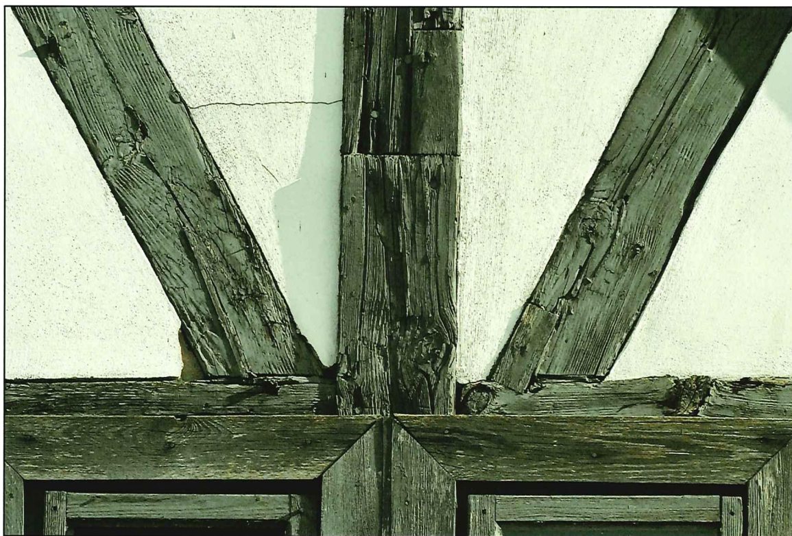
Il. 65 Golub-Dobrzyń, Rynek 19 – dom podcieniowy – szczyt szkieletowy - widok na zniszczenia konstrukcji szkieletowej szczytu
