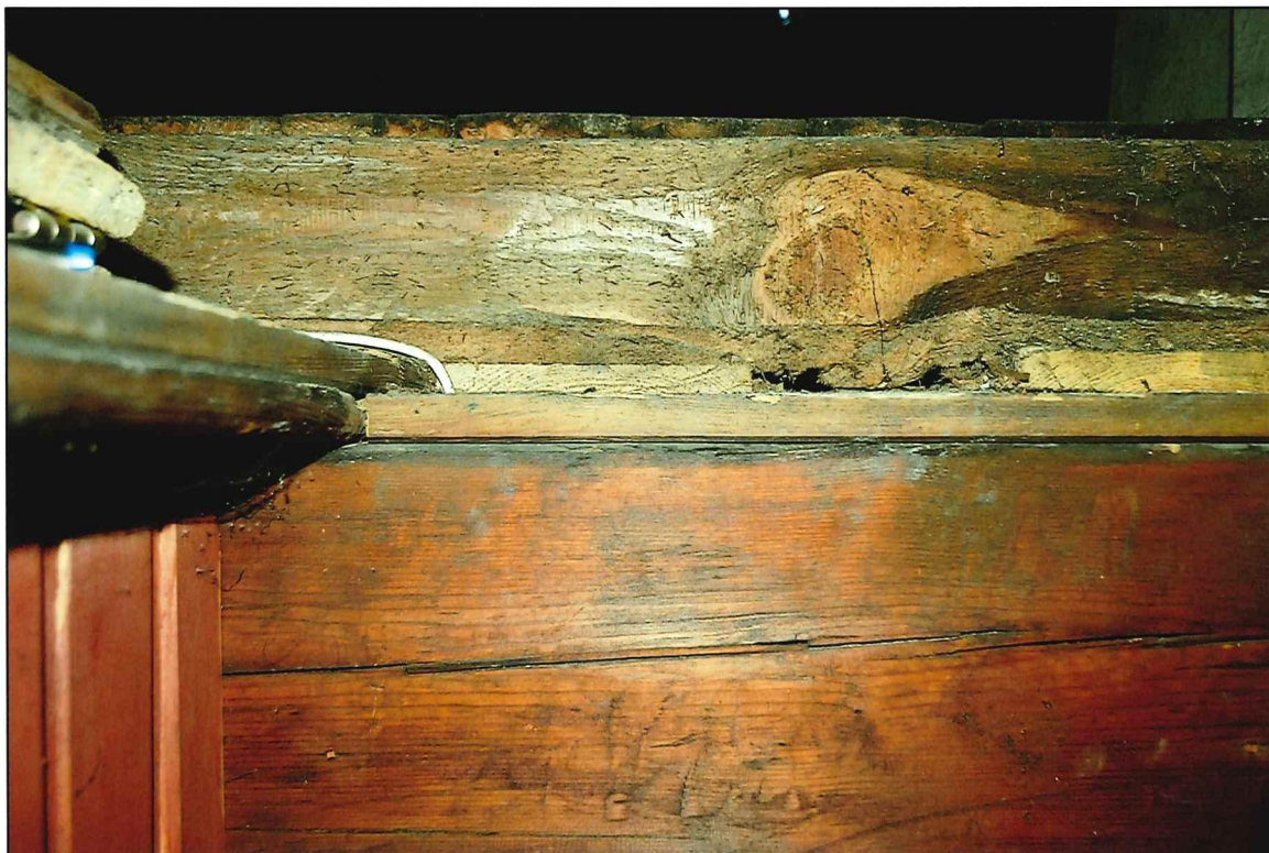
II. 170 Golub-Dobrzyń, Rynek 19 – dom podcieniowy, przyziemie - izba, strop belkowy, widok na przekrój
