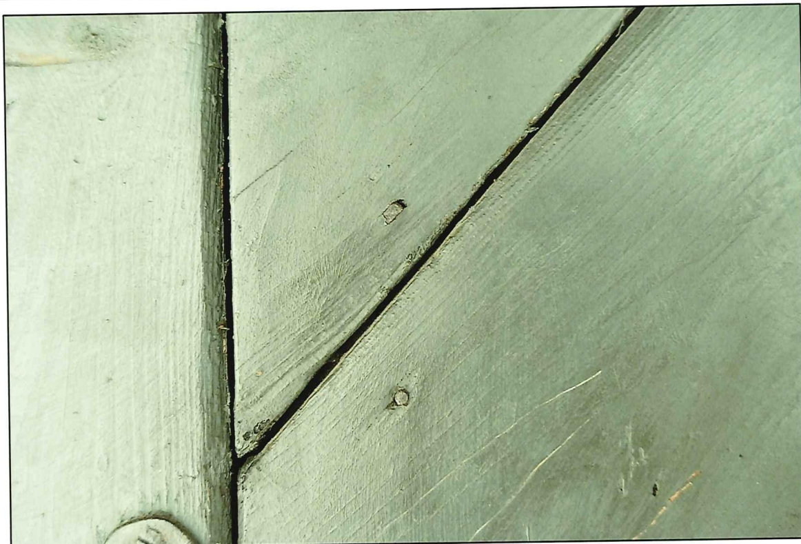
Il. 205 Golub-Dobrzyń, Rynek 19 – dom podcieniowy – główne wejście drzwiowe - widok sposób montażu opierzenia deskowego
