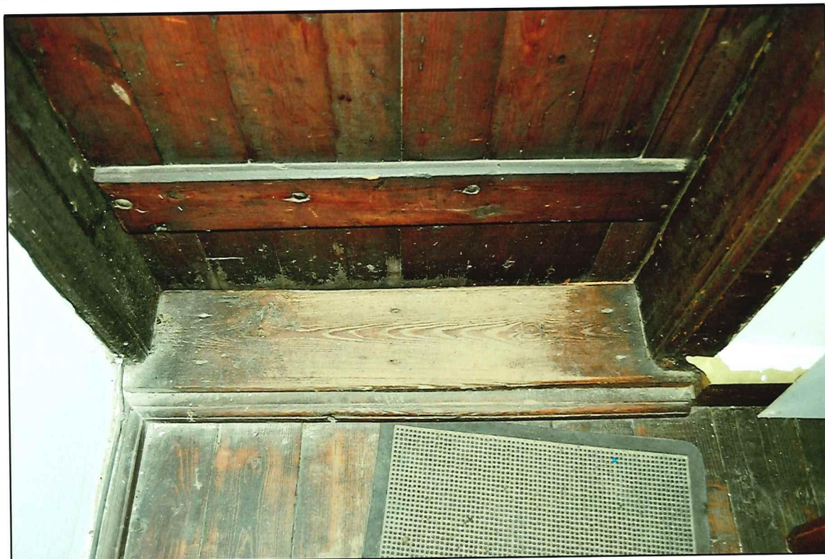
Il. 203 Golub-Dobrzyń, Rynek 19 – dom podcieniowy – główne wejście drzwiowe - widok na próg oraz fragmenty stojaków ościeżnicy drzwiowej
