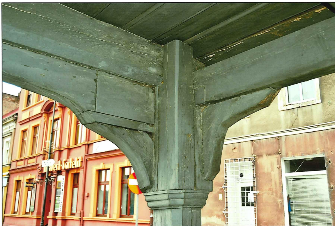
Il. 81 Golub-Dobrzyń, Rynek 19 – dom podcieniowy – podcień - widok na fragment konstrukcji drewnianej – słup północny
