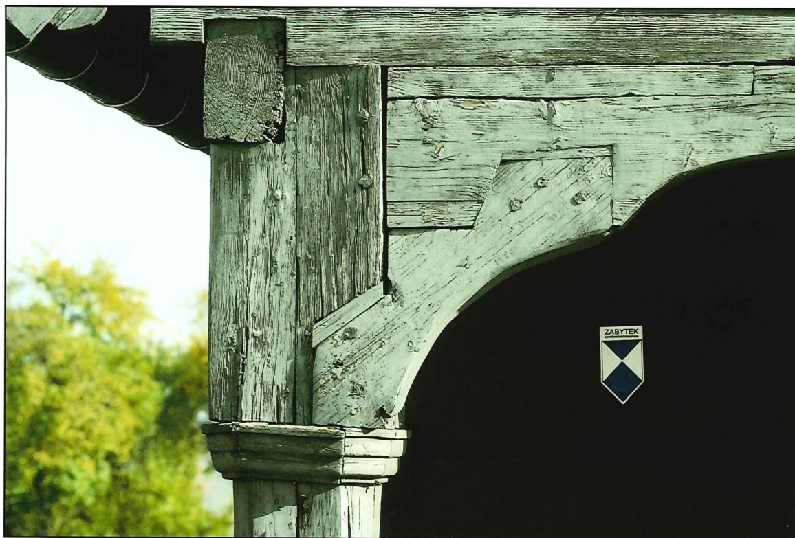
Il. 77 Golub-Dobrzyń, Rynek 19 – dom podcieniowy – podcień - widok na fragment konstrukcji drewnianej – słup północny
