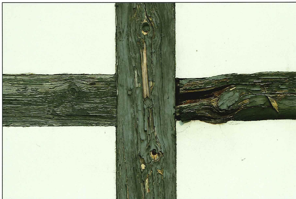
Il. 69 Golub-Dobrzyń, Rynek 19 – dom podcieniowy – szczyt szkieletowy - widok na fragment, wtórnej zniszczonej konstrukcji szkieletowej szczytu
