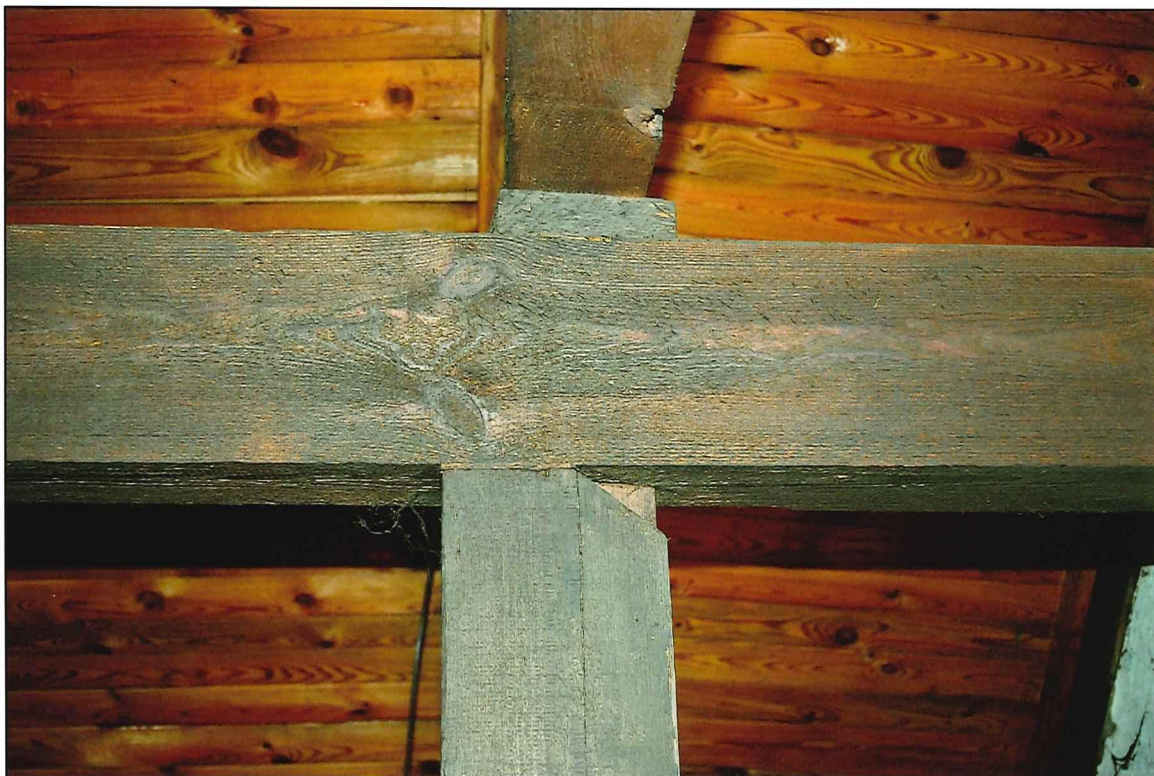
Il. 258 Golub-Dobrzyń, Rynek 19 – dom podcieniowy – konstrukcja dachowa - widok na fragment ramy stolcowej, połączenie czopowe stolca z płatwią
