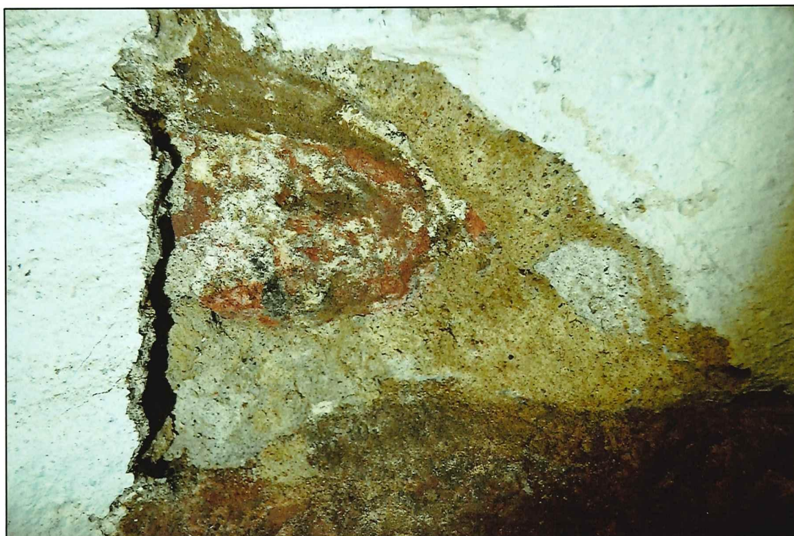
Il. 139 Golub-Dobrzyń, Rynek 19 – dom podcieniowy – piwnica - widok na wtórne, ceglane wypełnienia przestrzeni pomiędzy głazami ścian kamiennych
