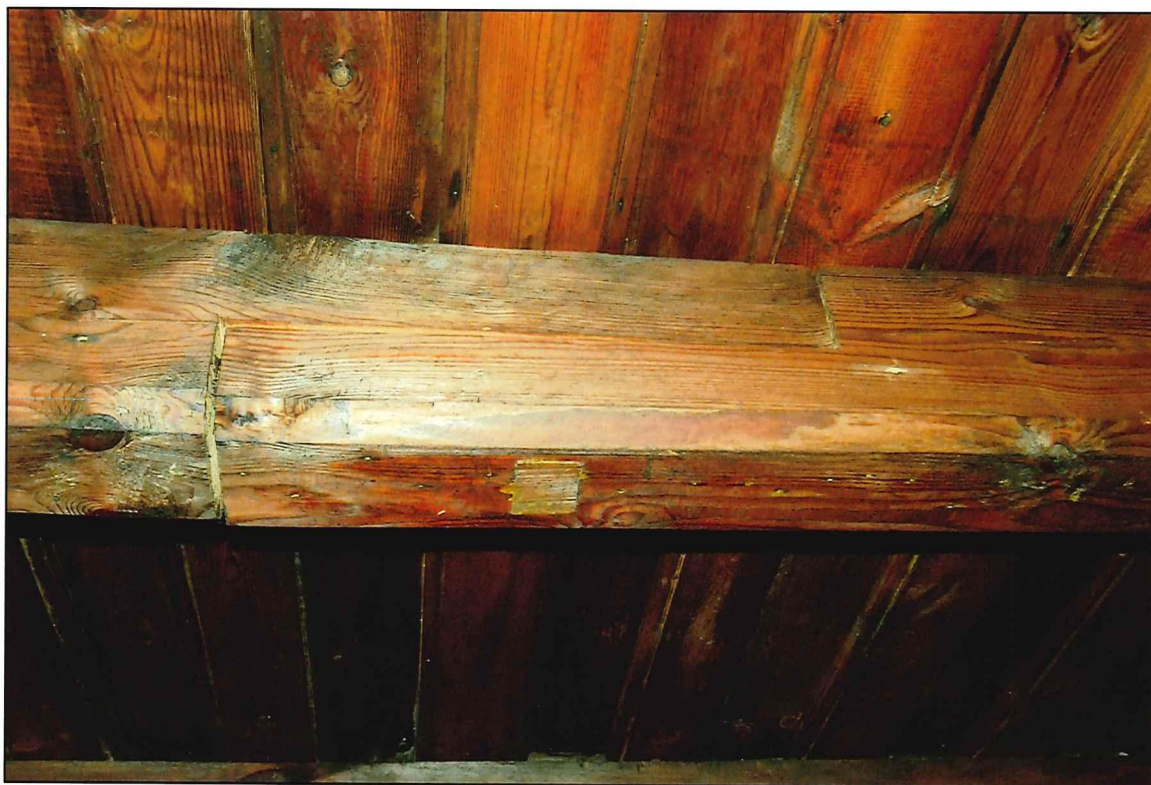
Il. 169 Golub-Dobrzyń, Rynek 19 – dom podcieniowy, przyziemie - izba, widok na połączenie wzdłużne jednej z belek stropowych
