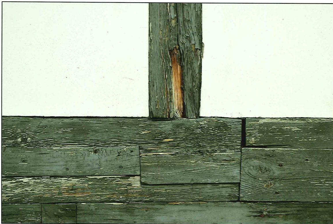
Il. 76 Golub-Dobrzyń, Rynek 19 – dom podcieniowy – podcień - widok na wtórne, odcinkowe naprawy oczepu
