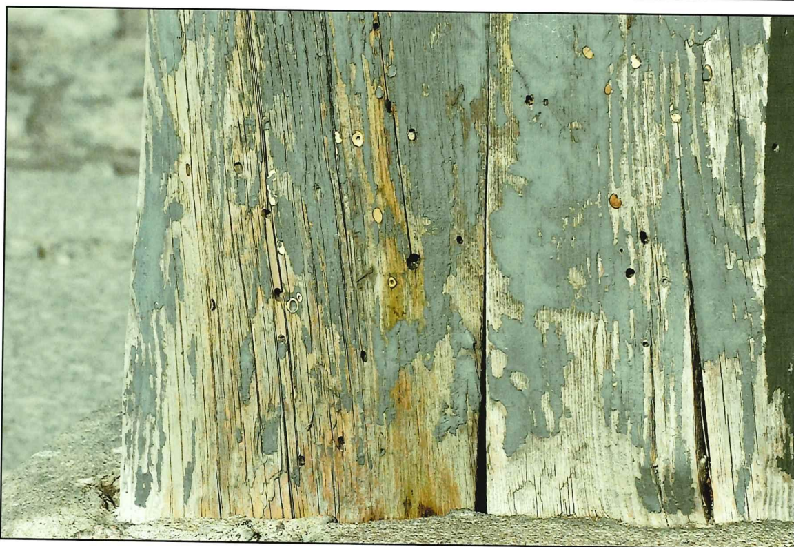
Il. 95 Golub-Dobrzyń, Rynek 19 – dom podcieniowy – podcień - widok na dolną część słupa ze śladami żerowania drewnojadów
