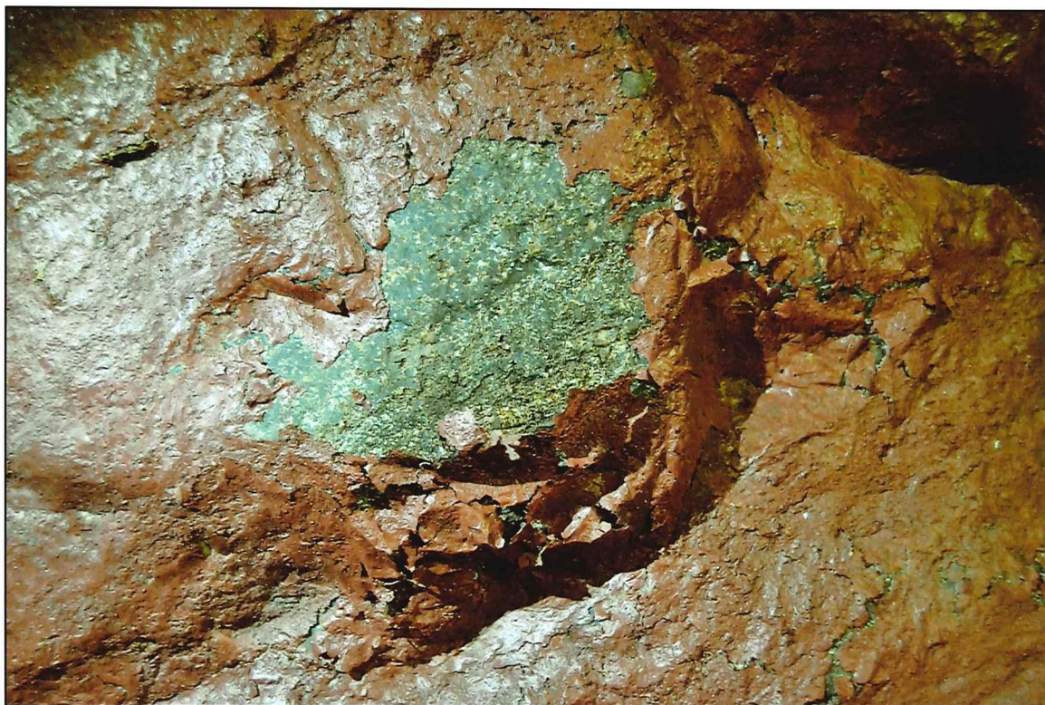
Il. 134 Golub-Dobrzyń, Rynek 19 – dom podcieniowy – podcień - fragment drewnianej powierzchni miecza zabezpieczonej farbą elewacyjną
