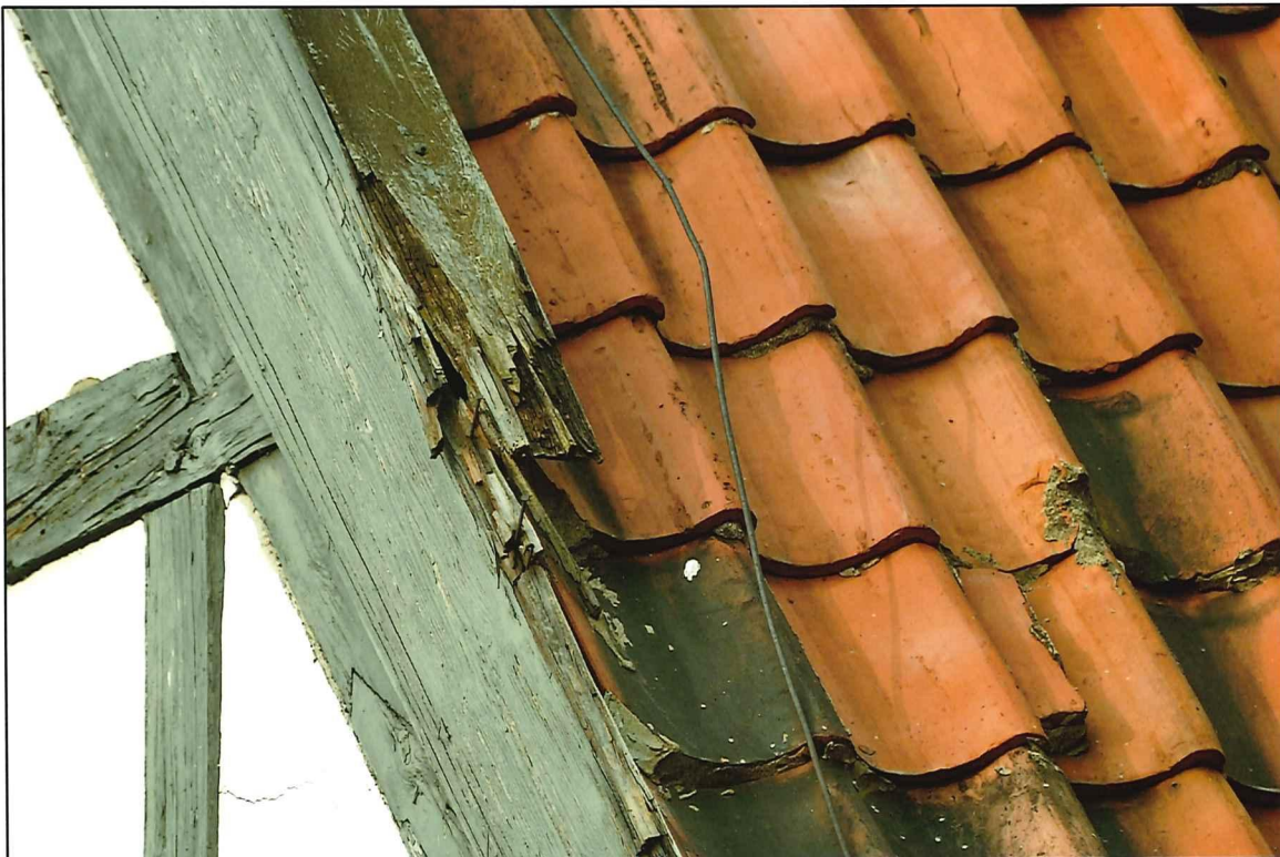
II. 234 Golub-Dobrzyń, Rynek 19 – dom podcieniowy – pokrycie dachowe - widok na fragment połaci południowej i zniszczoną wiatrownicę szczytową
