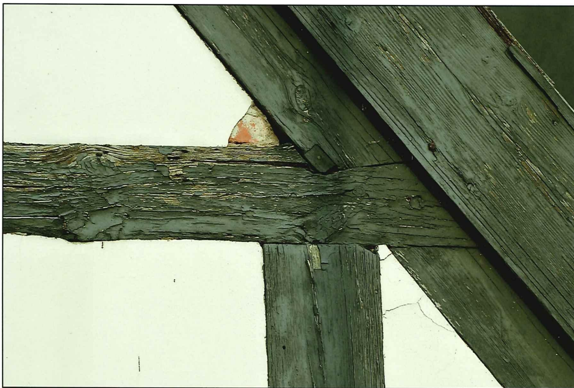
Il. 70 Golub-Dobrzyń, Rynek 19 – dom podcieniowy – szczyt szkieletowy - widok na fragment krokwi, wiatrownicy oraz jętki
