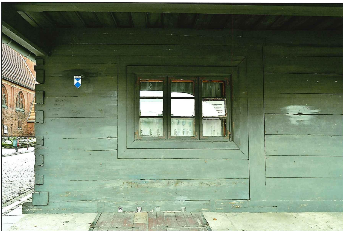
Il. 96 Golub-Dobrzyń, Rynek 19 – dom podcieniowy – podcień - widok na fragment wieńcowej ściany wschodniej
