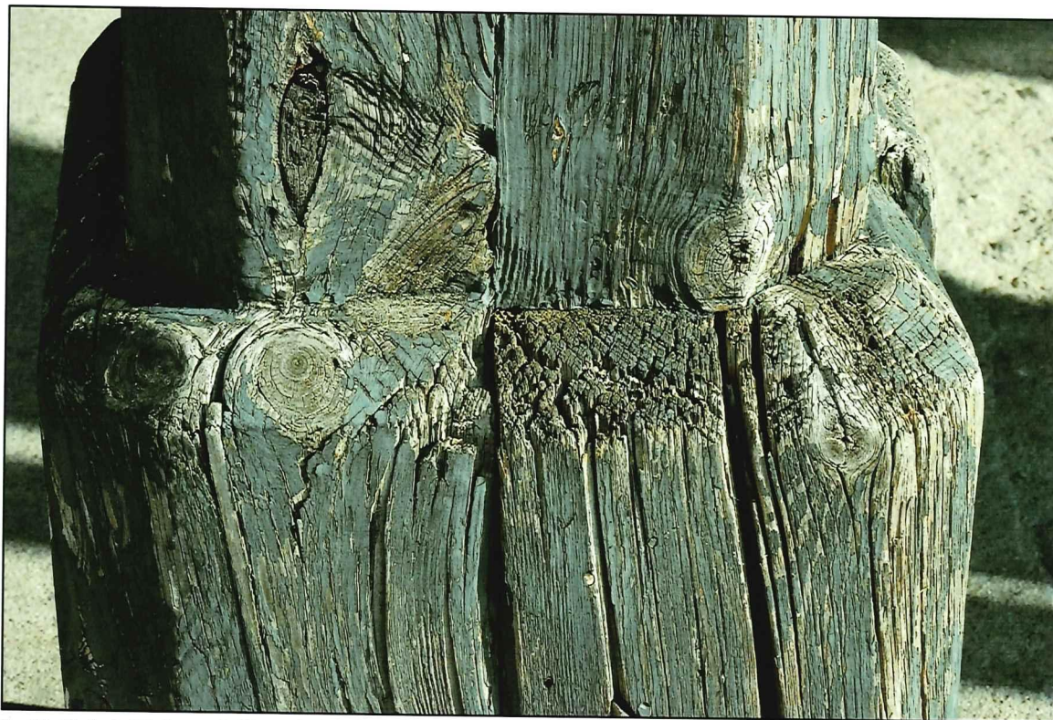
Il. 94 Golub-Dobrzyń, Rynek 19 – dom podcieniowy – podcień - widok na zniszczenia mechaniczne dolnego odcinka słupa
