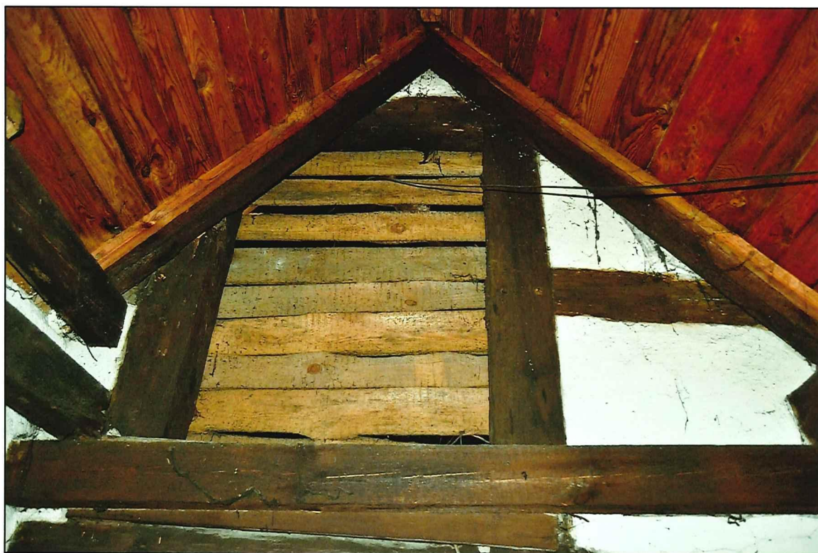
Il. 273 Golub-Dobrzyń, Rynek 19 – dom podcieniowy – szczyt zachodni tylnej zabudowy domu - widok na górną część szczytu szkieletowego
