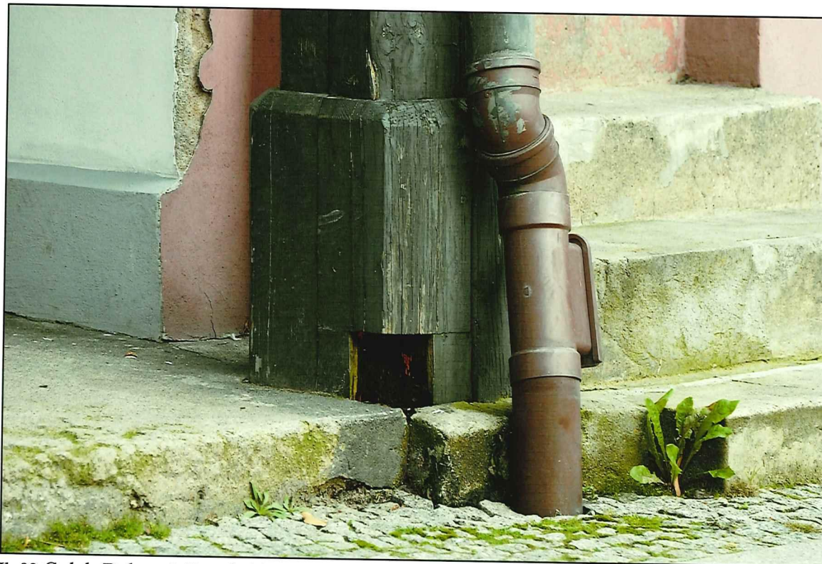
Il. 92 Golub-Dobrzyń, Rynek 19 – dom podcieniowy – podcień - widok na posadowienie oraz dolny odcinek słupa południowego
