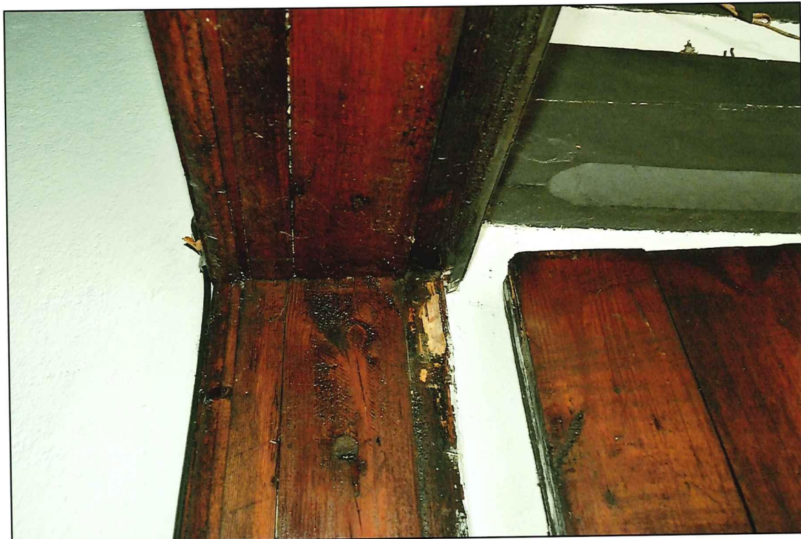
Il. 202 Golub-Dobrzyń, Rynek 19 – dom podcieniowy – główne wejście drzwiowe - widok na fragment nadproża oraz stojaka ościeżnicy drzwiowej
