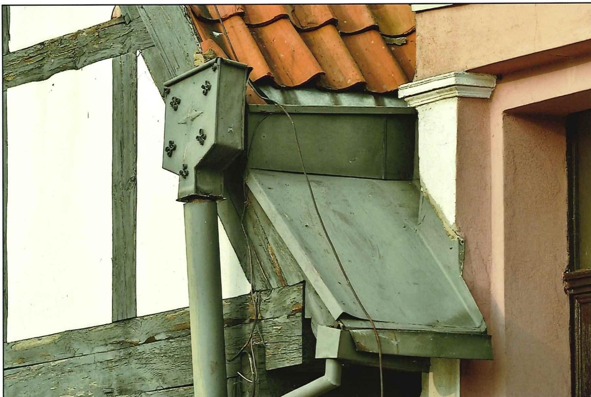
Il. 239 Golub-Dobrzyń, Rynek 19 – dom podcieniowy – pokrycie dachowe - widok na orynnowanie oraz fragment opierzenia blaszanego połaci południowej dachu
