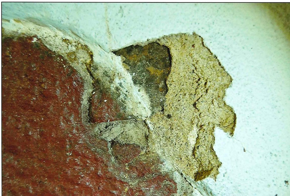
Il. 136 Golub-Dobrzyń, Rynek 19 – dom podcieniowy – piwnica - widok na wtórne spoinowanie kamiennej ściany
