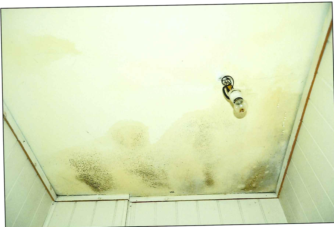
Il. 196 Golub-Dobrzyń, Rynek 19 – dom podcieniowy, przyziemie - dawna czarna kuchnia, obecnie pomieszczenie socjalno-sanitarne, widok na zawilgocony strop fot. Ewa Bożejewicz 2017 r.
