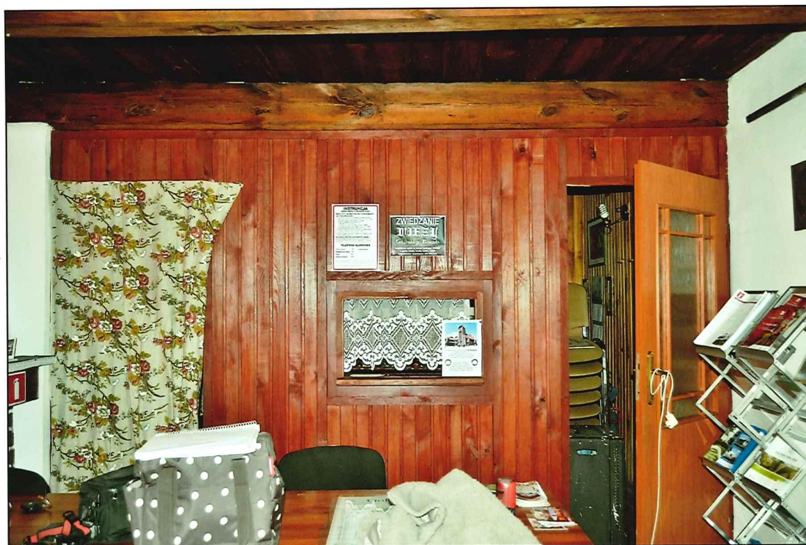
Il. 163 Golub-Dobrzyń, Rynek 19 – dom podcieniowy, przyziemie - izba, wschodnia ścianka drewniana z boazerii sosnowej
