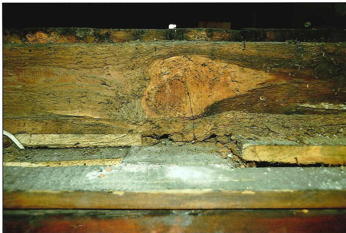
II. 171 Golub-Dobrzyń, Rynek 19 – dom podcieniowy, przyziemie - izba, strop belkowy, widok na pułapy deskowe oraz polepę w formie grubej płyty pilśniowej
