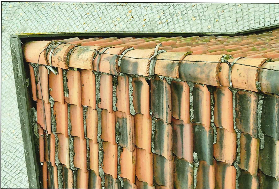
Il. 224 Golub-Dobrzyń, Rynek 19 – dom podcieniowy – pokrycie dachowe - widok na dekoracyjne gąsior w kalenicy dachu
