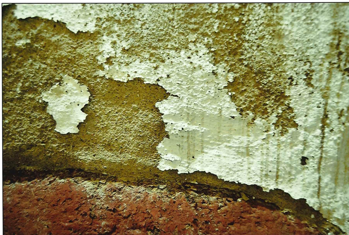
Il. 138 Golub-Dobrzyń, Rynek 19 – dom podcieniowy – piwnica - widok na ubytki i złuszczenia wtórnych warstw malarskich (ściana południowa)
