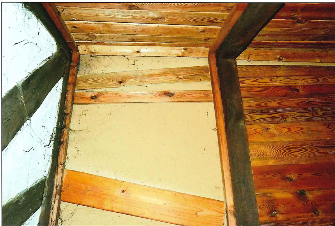
II. 250 Golub-Dobrzyń, Rynek 19 – dom podcieniowy – konstrukcja dachowa - widok na zniszczoną podbitkę deskową połaci północnej
