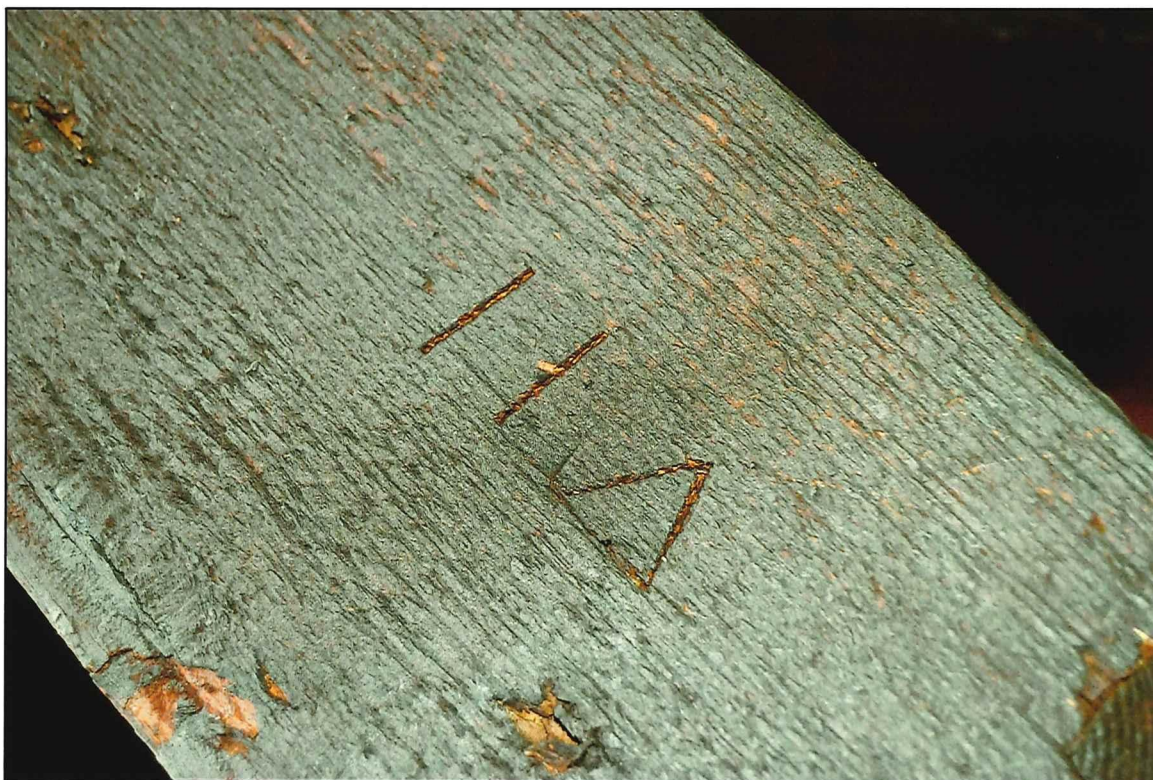
Il. 263 Golub-Dobrzyń, Rynek 19 – dom podcieniowy – konstrukcja dachowa - widok na znak ciesielski montażowy umieszczony na mieczu ramy stolcowej
