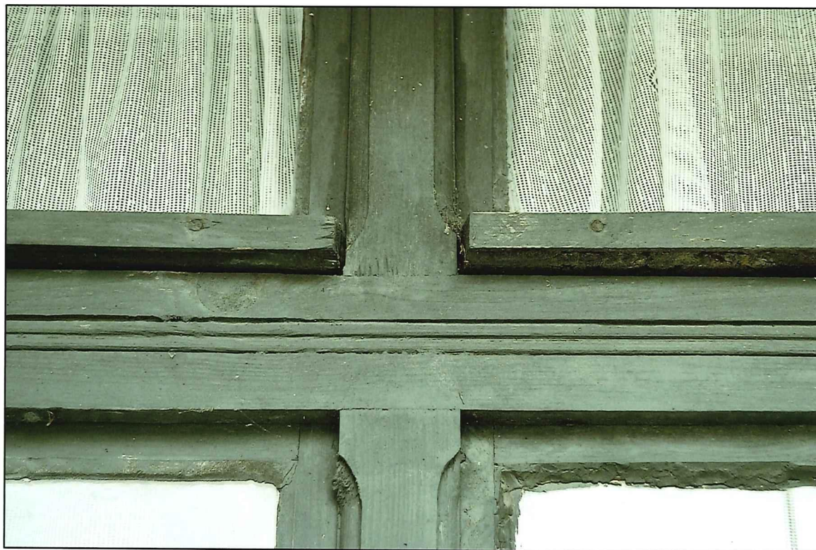
Il. 215 Golub-Dobrzyń, Rynek 19 – dom podcieniowy – stolarka okienna TYP II - widok na stolarkę krosnową – fragment krzyża okiennego z przechodzącym ślemieniem
