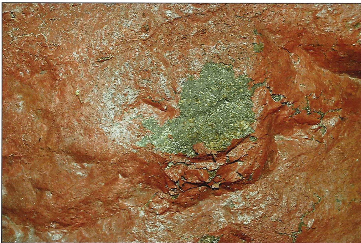
II. 133 Golub-Dobrzyń, Rynek 19 – dom podcieniowy – piwnica - widok na wtórne przemalowanie powierzchni głazów murów kamiennych farbą olejną
