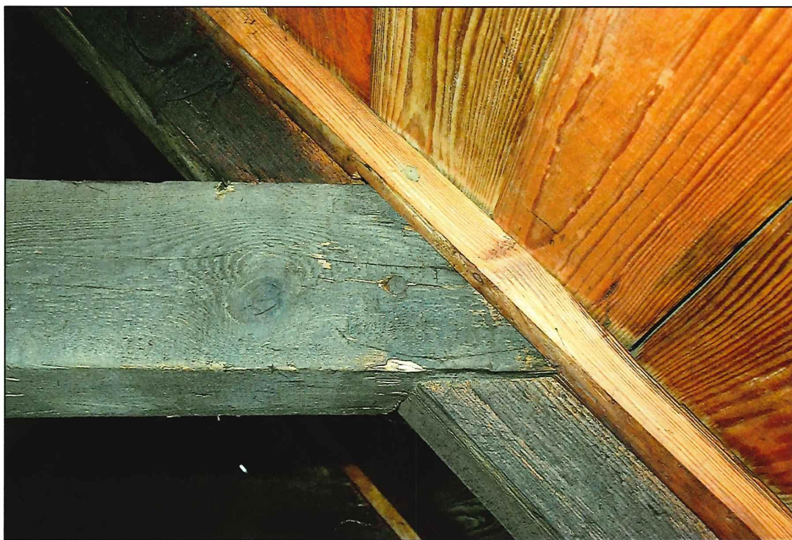
Il. 245 Golub-Dobrzyń, Rynek 19 – dom podcieniowy – konstrukcja dachowa - widok na połączenie nakładkowe krokwi z jętką
