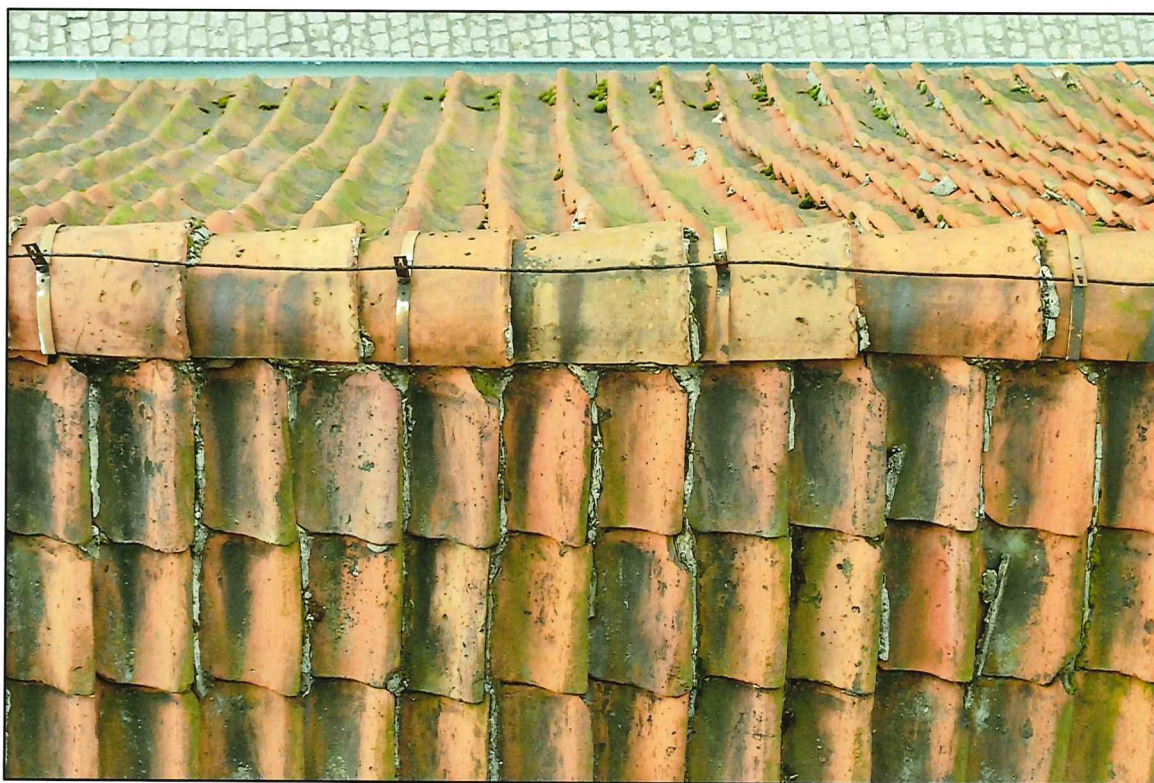
Il. 225 Golub-Dobrzyń, Rynek 19 – dom podcieniowy – pokrycie dachowe - widok na dekoracyjne gąsior w kalenicy dachu
