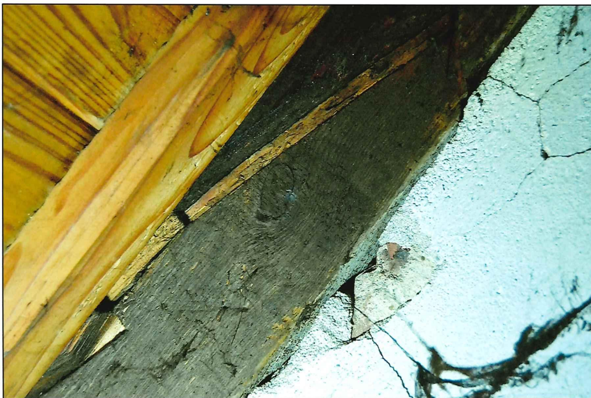
Il. 268 Golub-Dobrzyń, Rynek 19 – dom podcieniowy – szczyt zachodni - widok na uszkodzenia krokwi szczytowej
