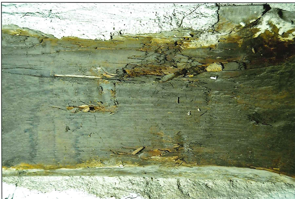
Il. 270 Golub-Dobrzyń, Rynek 19 – dom podcieniowy – szczyt zachodni - widok na fragment konstrukcji szkieletowej uszkodzonej mechanicznie
