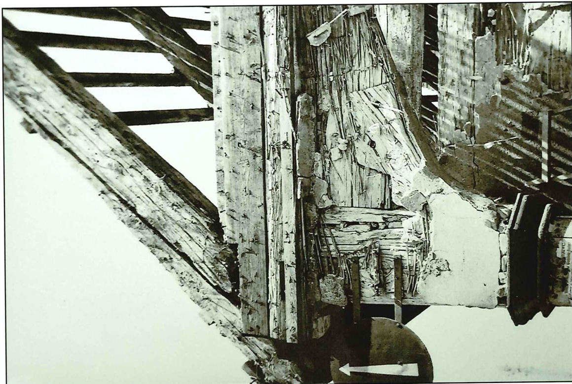
Il. 21 Golub-Dobrzyń, Rynek 19 – dom podcieniowy podczas prac remontowych w 1963 r. - widok na fragment konstrukcji drewnianej podcienia
