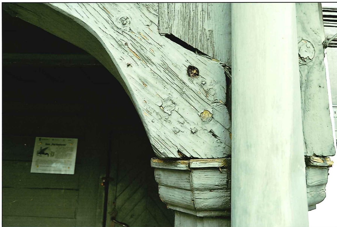
Il. 85 Golub-Dobrzyń, Rynek 19 – dom podcieniowy – podcień - widok na zniszczenia słupa południowego
