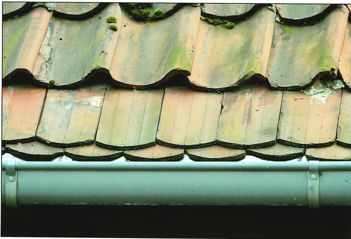
II. 231 Golub-Dobrzyń, Rynek 19 – dom podcieniowy – pokrycie dachowe - widok na fragment okapu połaci północnej, przekrytego dachówką karpiówką ułożoną w koronkę
