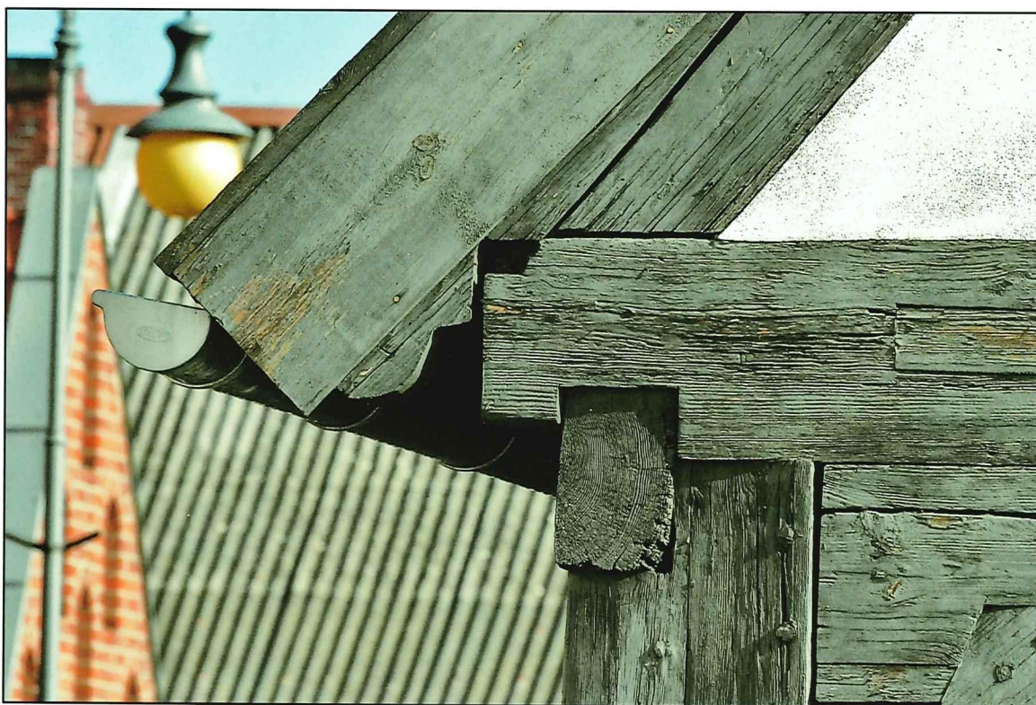
Il. 73 Golub-Dobrzyń, Rynek 19 – dom podcieniowy – podcień - widok na fragment konstrukcji drewnianej – połączenie czepów ze słupem podcienia
