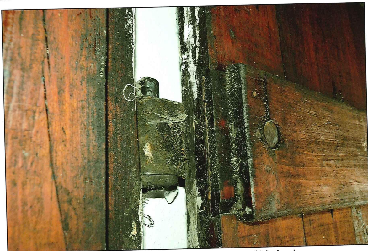
Il. 200 Golub-Dobrzyń, Rynek 19 – dom podcieniowy – główne wejście drzwiowe - widok na fragment stolarki, zawias oraz konstrukcję deskowo-biegunowa skrzydła
