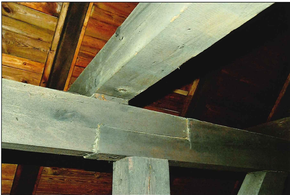
Il. 257 Golub-Dobrzyń, Rynek 19 – dom podcieniowy – konstrukcja dachowa - widok na fragment jętki i podpierającej ją ramy stolcowej
